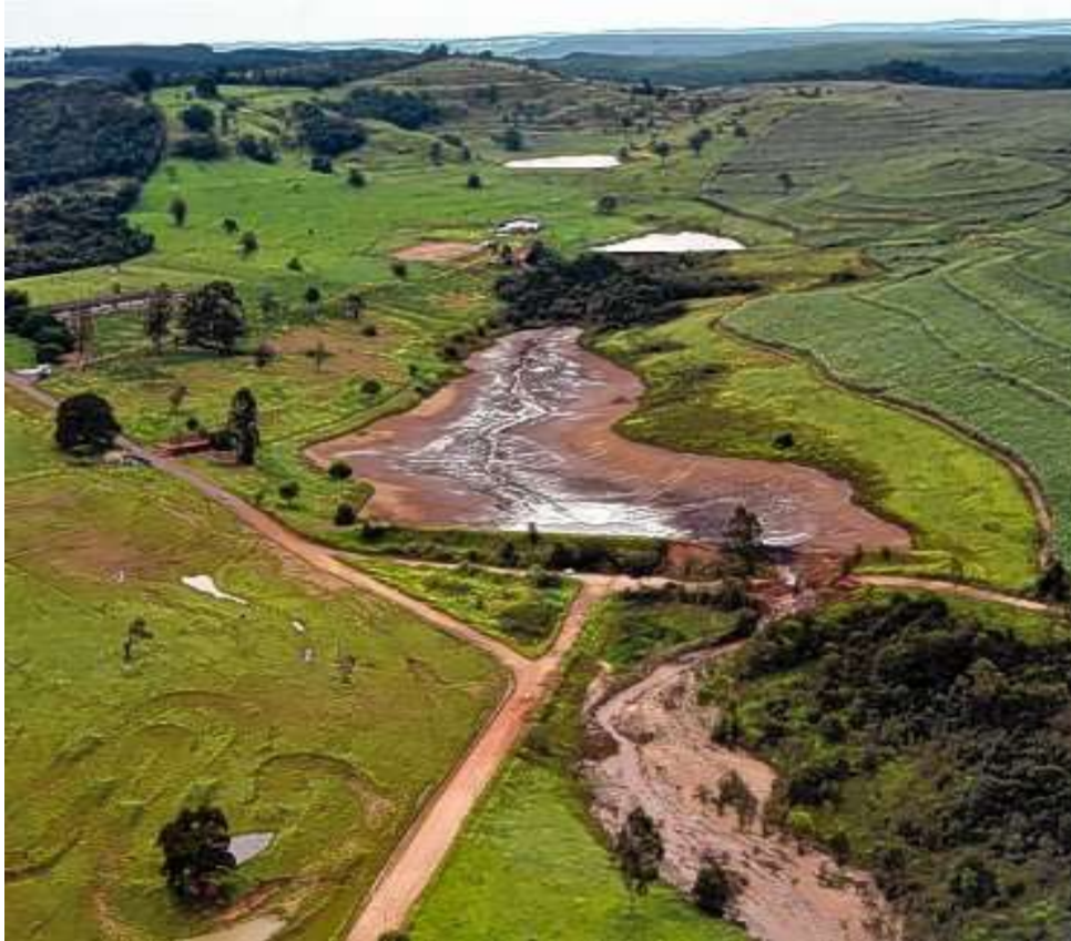
Figura 4: Foto aérea oblíqua de 2016 mostrando a situação e vestígio de uma das represas depois do rompimento.
